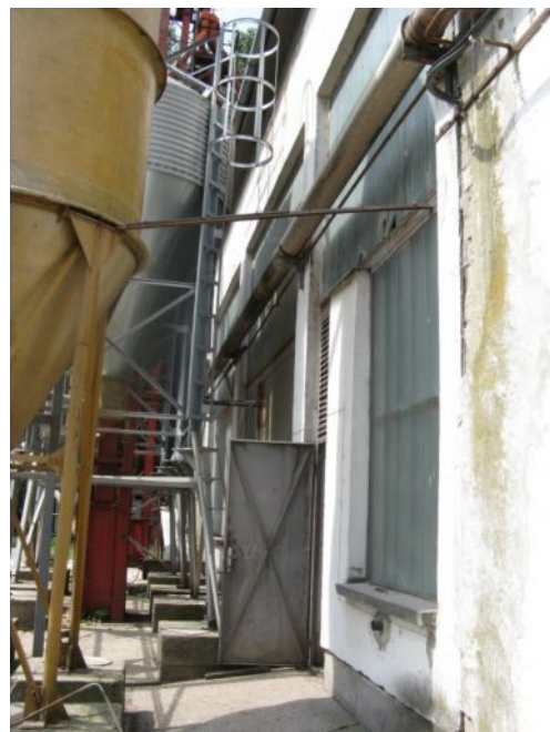
Takarmánysiló szerelőlétrájának védőkarimája kb. 4 méteres magasságban kezdődött
