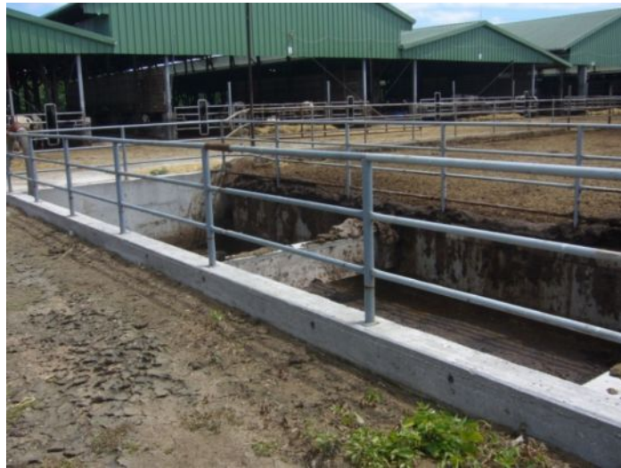
Szarvasmarhatartó telep hígtrágya tárolója beesés elleni védőkorláttal ellátva
