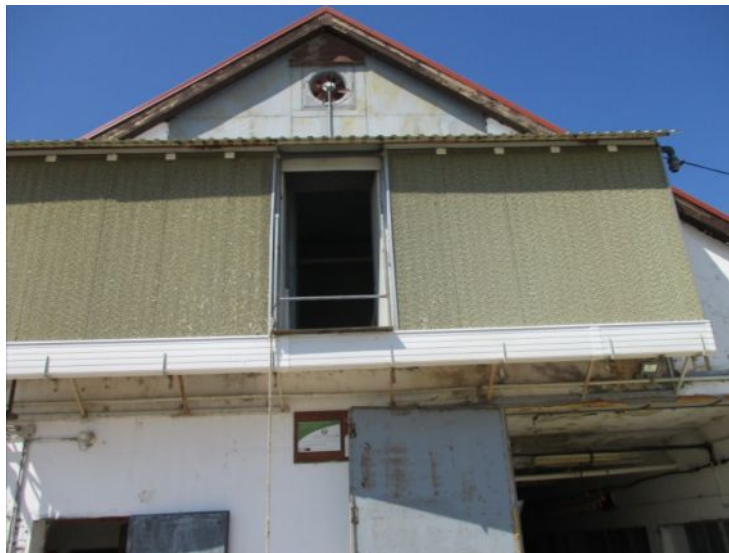
Padláson kialakított baromfi istálló nyitott ajtaja leesés elleni védelem nélkül
