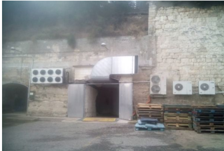
Gombapince bejárata szellőztető és klimatizáló berendezésekkel ellátva
