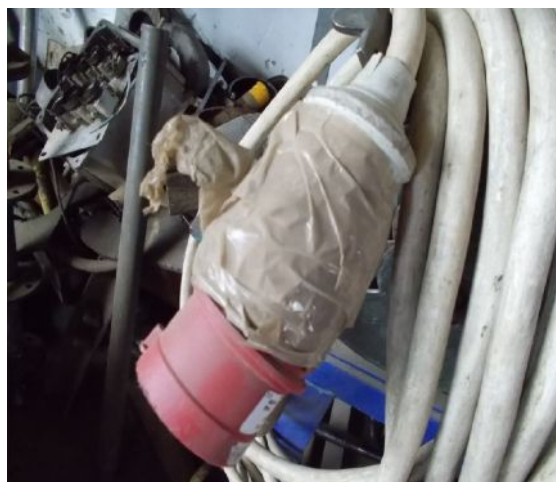
Sérült, illetve nem megfelelően javított villamos vezetékek és aljzatok
