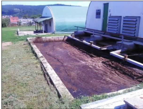
A 3,0 – 3,5m mély hígtrágya tárolónál a beesés elleni védelem hiányzott
